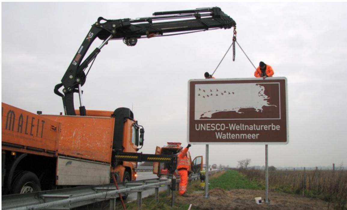
Aufbau eines Hinweisschildes an der Autobahn | © M. Stock/LKN-SH
