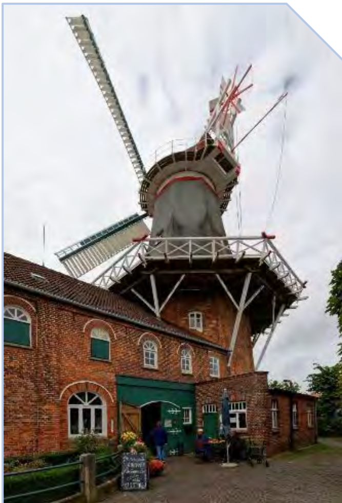
Abbildung 22 ▶ Die Westgaster Mühle in Norden, ein sogenannter Galerieholländer. Der Gastronomiebetrieb im angeschlossenen Wirtschaftsgebäude ist Nationalpark-Partner (Quelle: U. Skrzypczak/demipress, NLPV)
