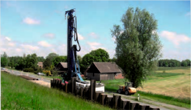
Einbringen der Spundbohlen entlang der Straße.
