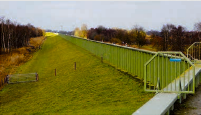
Der fertiggestellte Deich.
