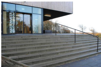
Treppe auf dem Weg vom Parkplatz und ÖPNV zum Eingang
