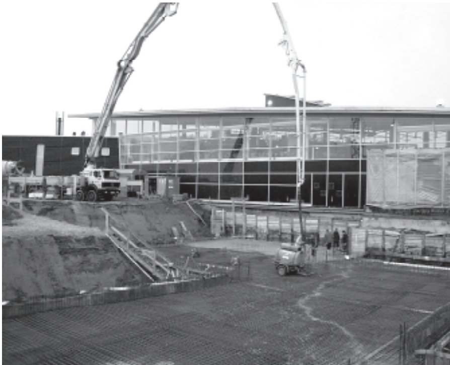
Potsdamer Platz? Nein! Auch am Multimar wird emsig gebaut.
