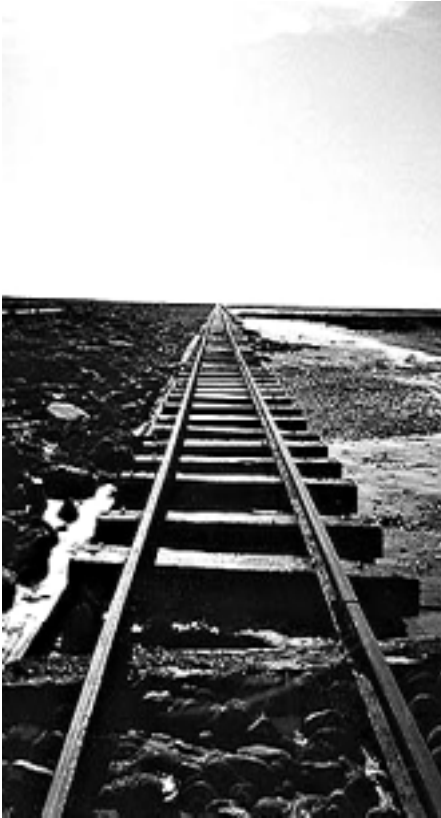
Sanierungsfall: der Oländer Damm.
