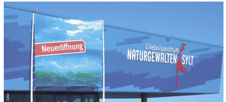
„Bewegung“ als Leitgedanke der Architekten Johannsen und Fuchs aus Husum: ein bewegter Baukörper spiegelt die bewegte Landschaft und die Kraft und Gewalt der Natur wider.
